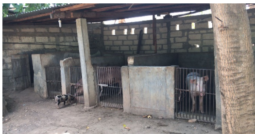
Kandang permanen dari semen beton
