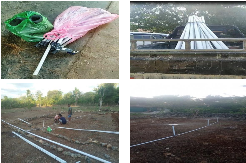
Gambar 7. Pengadaan dan Pemasangan Pipa Irigasi
