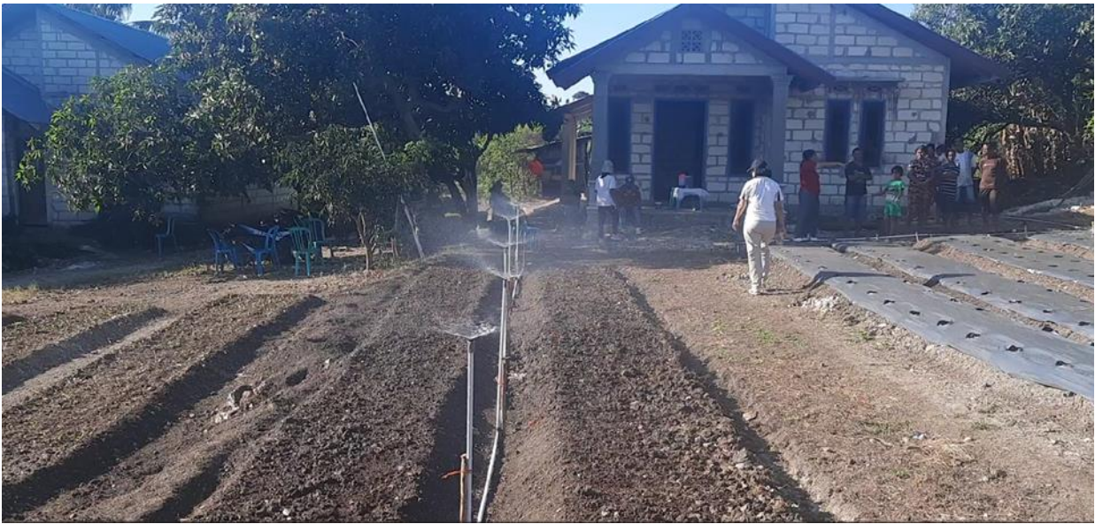
Gambar 6. Kegiatan instalasi sprinkler, penanaman, dan uji coba sprinkler
