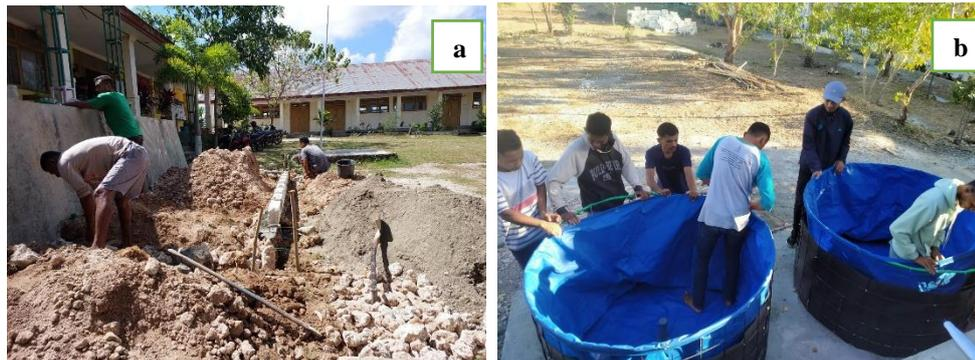
Gambar 2. (a) Kegiatan pembuatan alas kolam berupa beton, (b) Perakitan dan pemasangan kolam wermesh.
