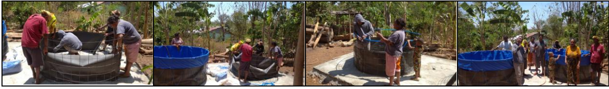
Gambar 4. Proses pembangunan, konstruksi dan tampilan kolam flog siap digunakan untuk pembesaran ikan lele
