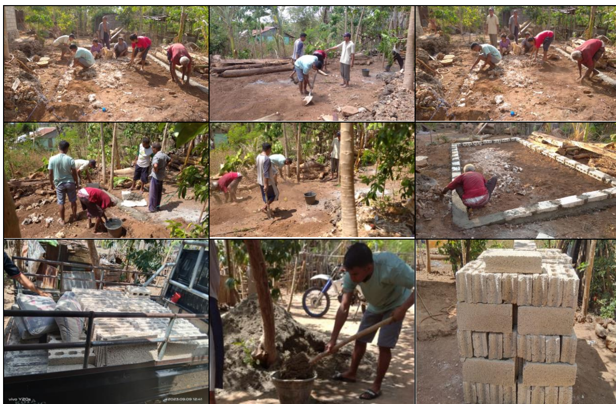
Gambar 3. Pengadaan material dasar kolam dan persiapan lahan untuk kolam flog pembesaran ikan lele
