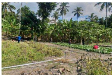
Penyambungan Pipa 1.5 ke Pipa 0.5 dim
